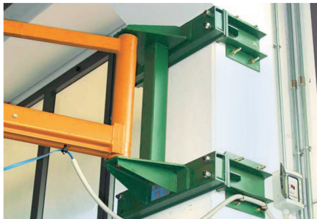
Imbragatura mediante tasselli chimici. Chemical bolts anchoring.
